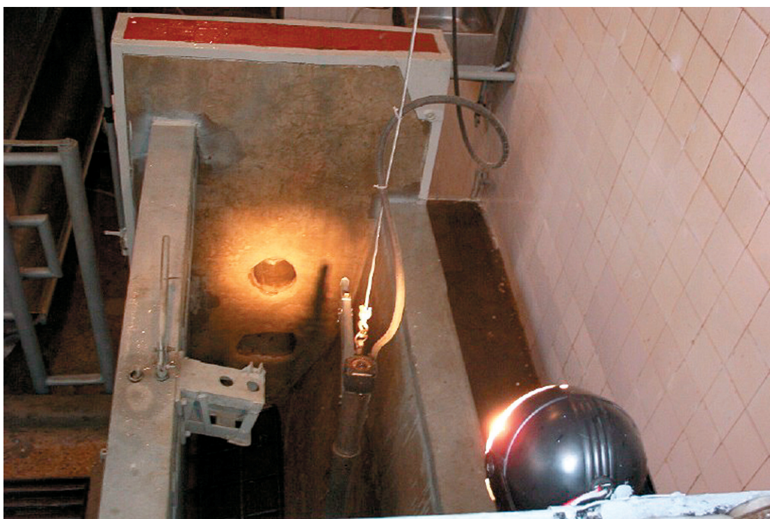
Fig. N° 11. Iluminación de la pared frontal del cajón de noqueo. Frigorífico La Caballada. Departamento de Salto.
