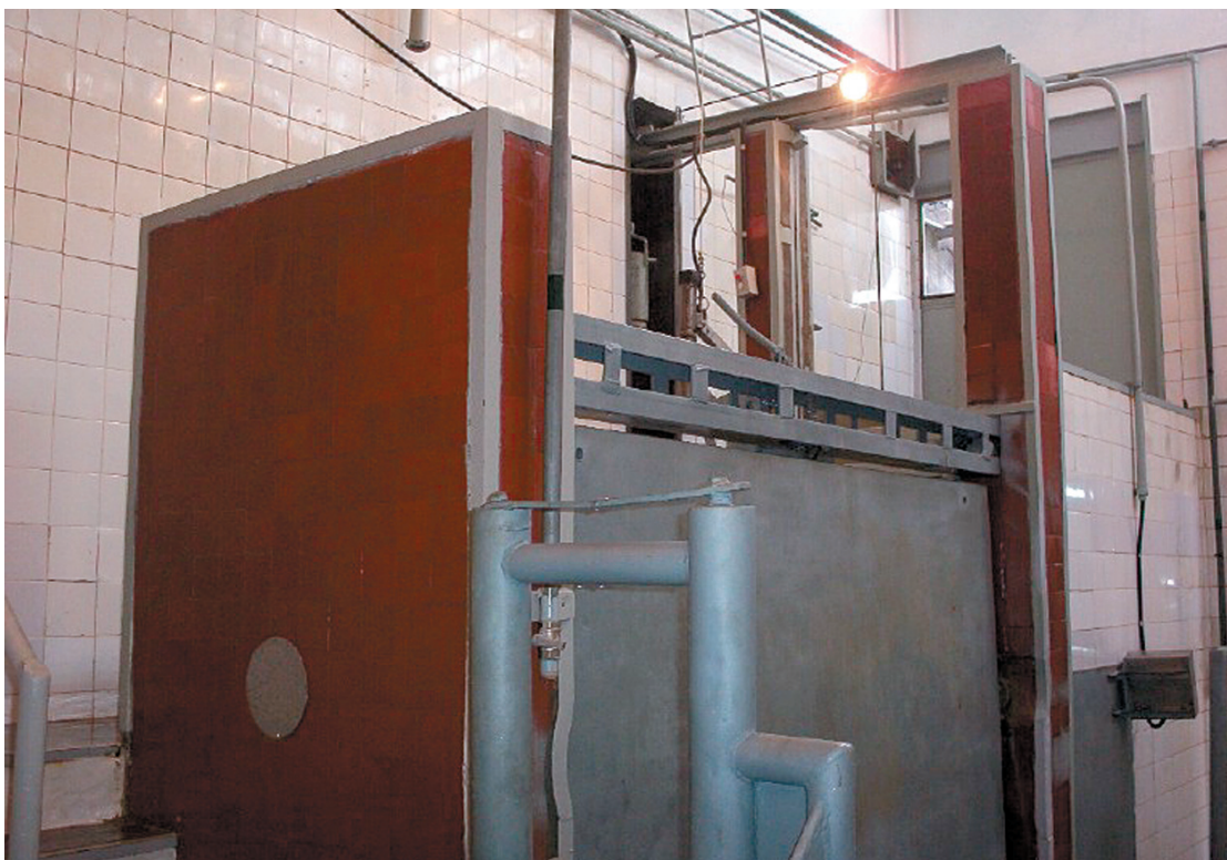
Fig. N° 10. Cajón de noqueo con luminaria. Frigorífico La Caballada, Departamento de Salto.
