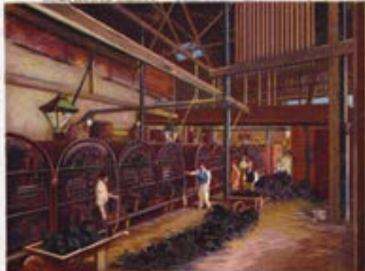
CHAMBRE des CHAUDIÈRES
