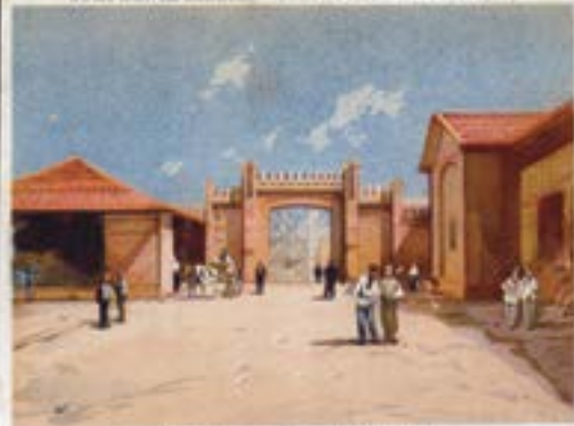
PORTE D'ENTRÉE PRINCIPALE
